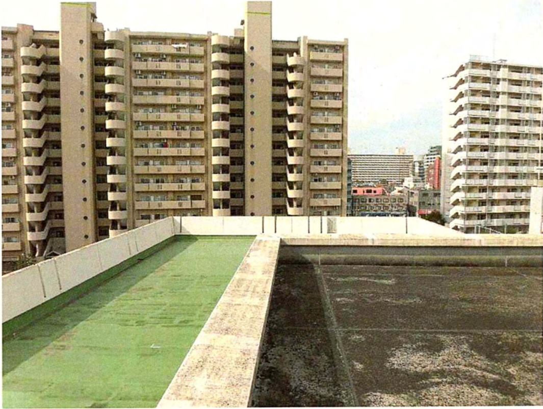
第三大島小学校屋上
